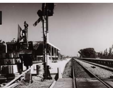
NS-station Purmerend Overwhere in aanbouw, 1971.
